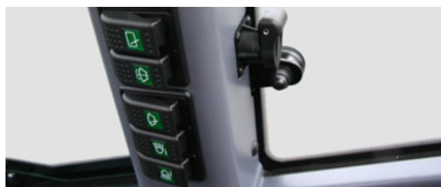
Gecentraliseerd schakelaarsveld, stopcontact met gelijkstroom
